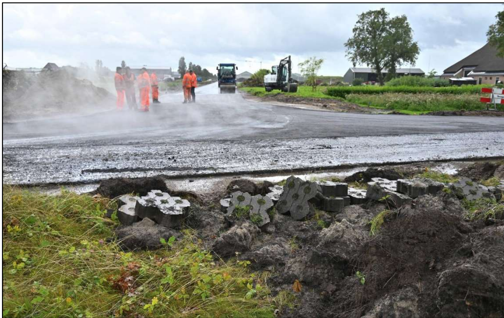
De aanleg van de ontsluitingsweg op het Haakswold. (Foto: Peter Nefkens)
